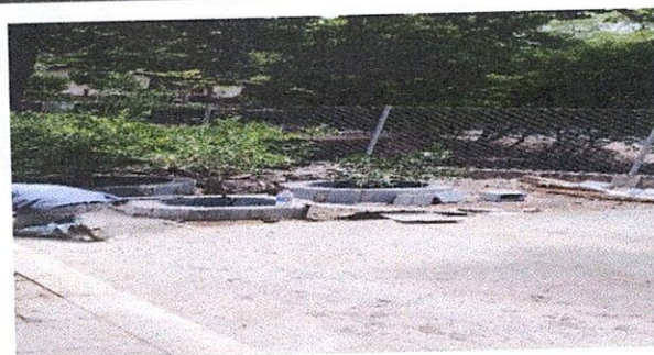
Foto 4: Reparación de losa de concreto para patios, considerando preparación de terreno, armado, nivelación y acabado rustico.
