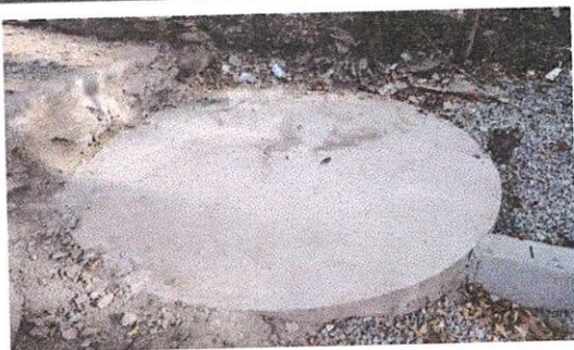
Foto 3: Mantenimiento a fosa séptica.
