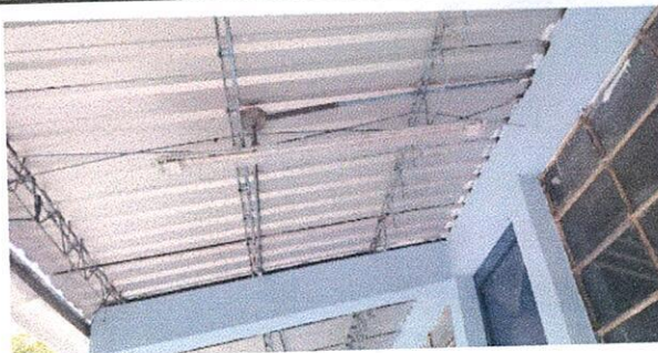
Foto 2:Sustitucion de sistemas de iluminación: Lámparas
